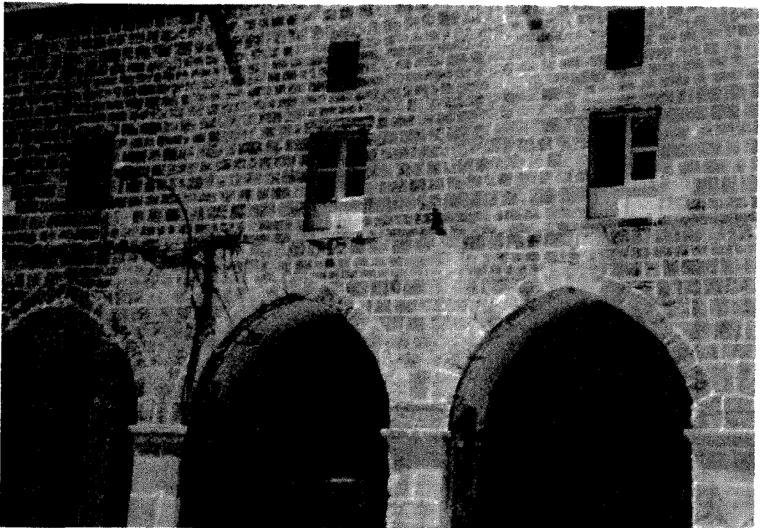
المدرسة الأشرفية من الواجهة الشرقية
