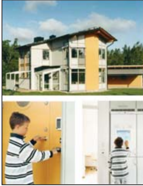
الشكل رقم (٦-١٠). مسكن ذكي في استوكهولم (٥١). يوضح الشكل طريقة فتح الباب بالبصمة، وشاشة التحكم الداخلية Screenfridge في عناصر المسكن.
