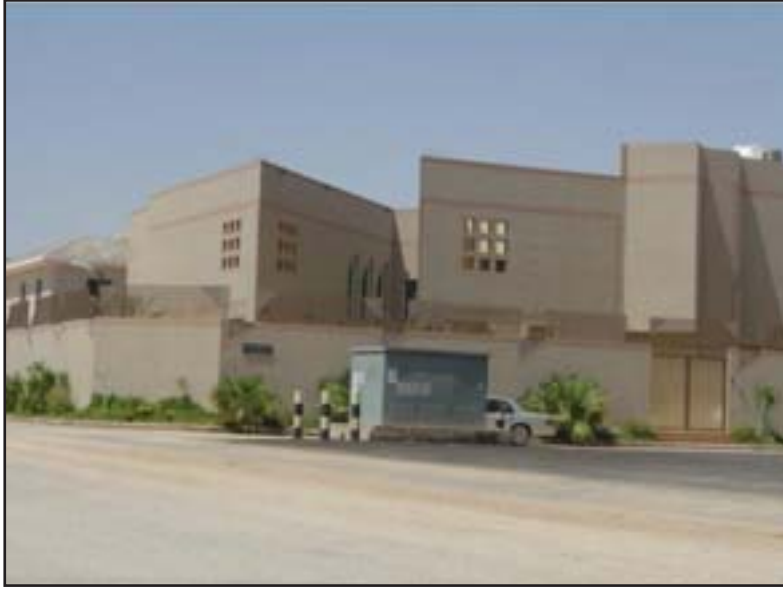
الشكل رقم (٢-٩). الأسوار والواجهات الخارجية الصماء لحماية الفراغات الداخلية والفراغات المحيطة في الفلل، بمدينة الرياض.
